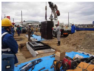
事前検証の全景(延長約10m)
