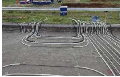
ケーブルを舗装に埋設
