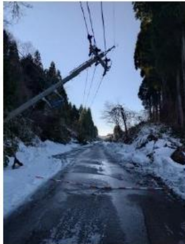
石川県輪島市 広域農道
