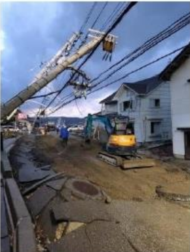
石川県輪島市 国道249号
