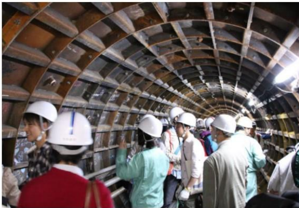
工事中のトンネルウォークの様子
