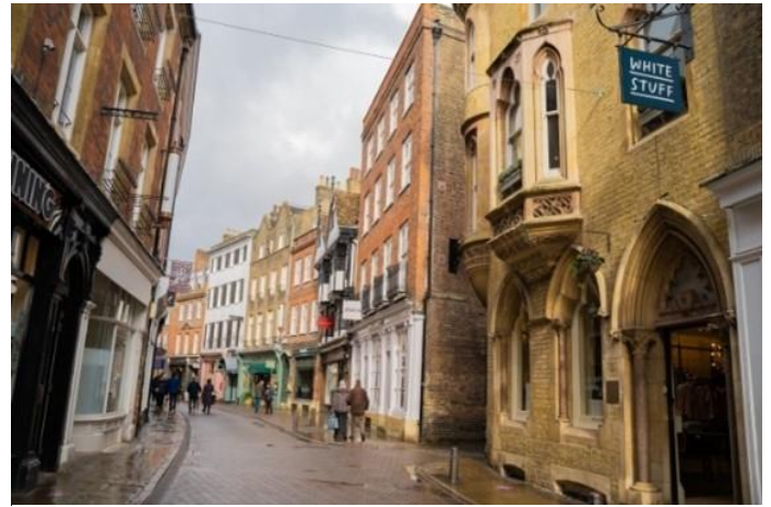
ロンドンの無電柱化された街並み
