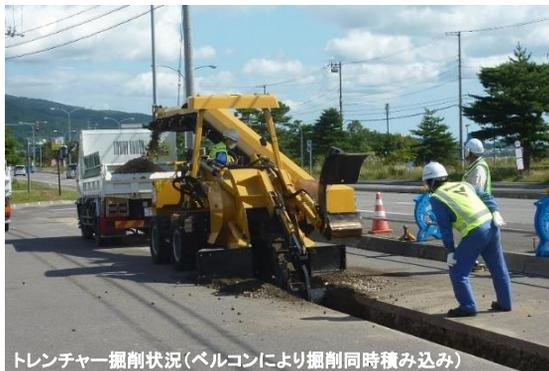
トレンチャー掘削状況(バルコンにより掘削同時積み込み)
