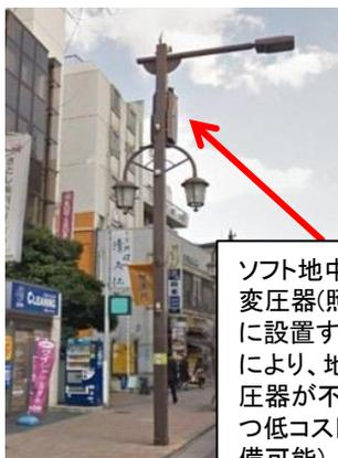
ソフト地中化用変圧器(照明柱に設置することにより、地上変圧器が不要かつ低コストで整備可能)
