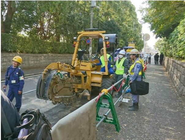
「直接埋設方式「直接埋設方式による無電柱化(常設作業帯コンパクト化等)」実証実験(通信ケーブルのみ)
