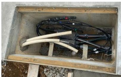
※電力と通信の宅内樹は通常、独立して設置するが、今回は共用 (W450×H500×L1,000) にすることでコスト削減と省スペース化を図った。また、π方式を採用することで停電時のリスクをヘッジした。
