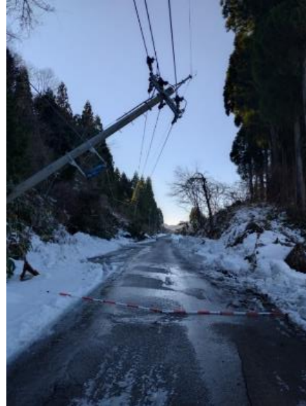
石川県輪島市 広域農道
