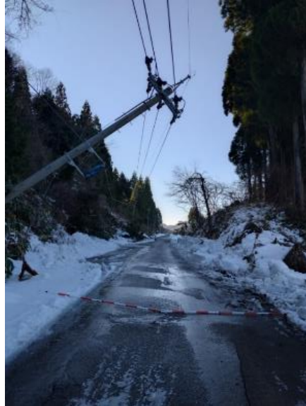
石川県輪島市 広域農道
