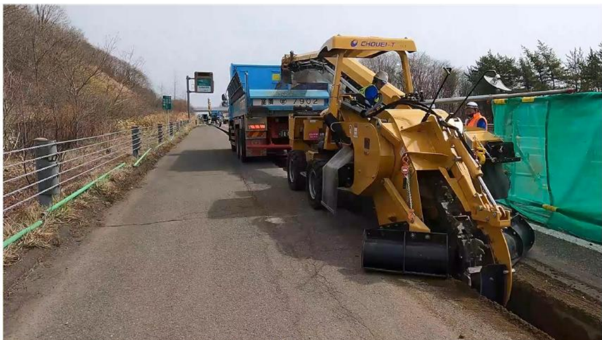
▲R5道中央自動車道通信管路敷設工事でのトレンチャー活用事例
