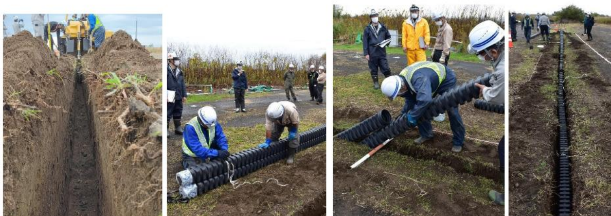
▲幅20cm掘削断面の敷設試験（令和4年度寒地土木研究所試験施工）
