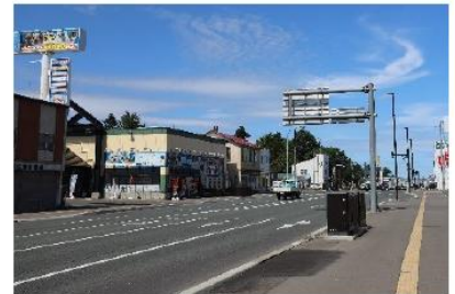
速やかな電柱撤去
