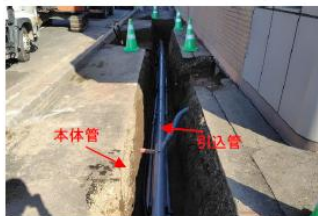
本体管と連携・引込管の同時施工
