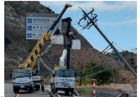
道路啓開作業
