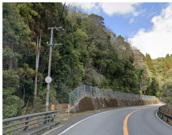
<大分県擁壁部>
