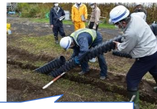
▲狭隘断面での落とし込み敷設
