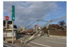
【令和6年1月 能登半島地震による電柱倒壊状況】 （石川県輪島市）
