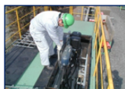
地上での接続作業
