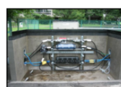
構内での接続作業
