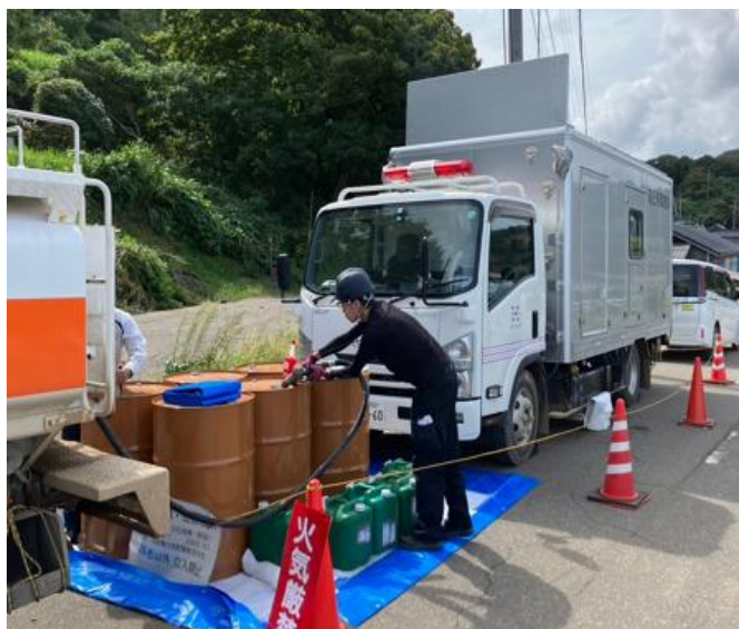
【令和6年奥能登豪雨への対応について】電源車からの仮設住宅への応急送電作業 (送配電網協議会より提供)
