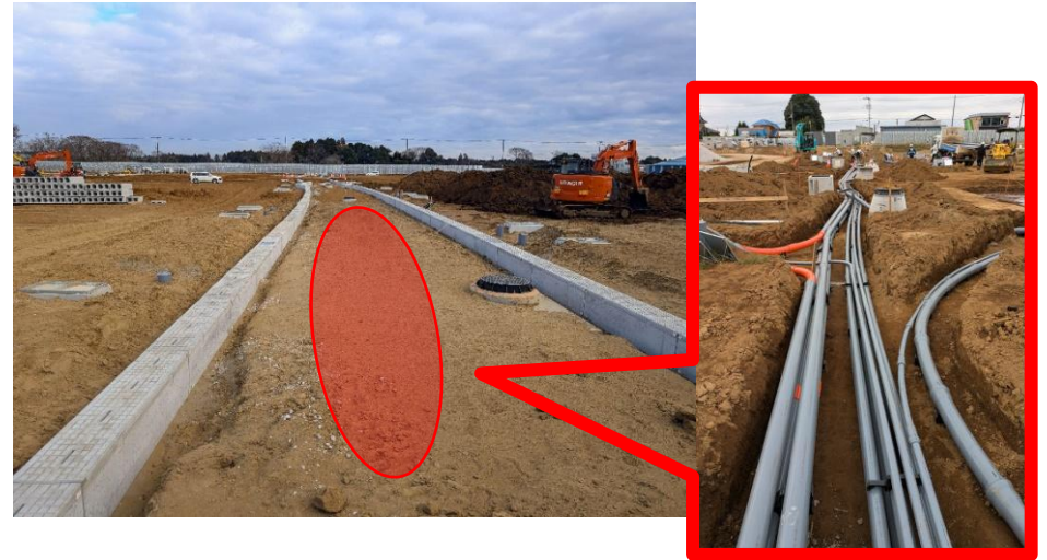
無電柱化まちづくり促進事業を活用した無電柱化の実施事例(千葉県芝山町)
