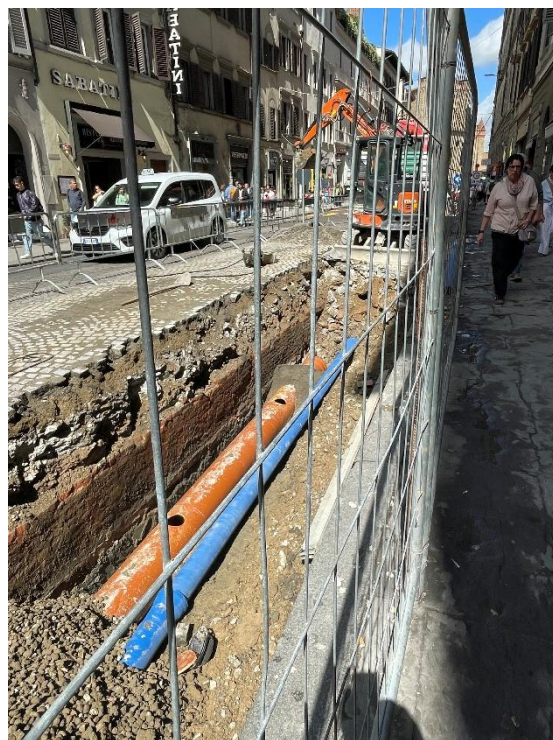
フィレンツェの上下水工事（地下に歴史的なレンガ構造あり）
