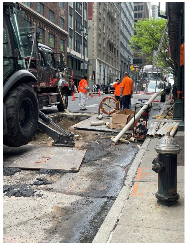
同地での光ファイバー地下敷設
