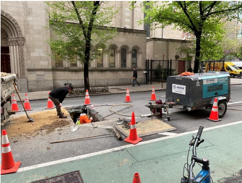
マンハッタンでの上下水道工事
