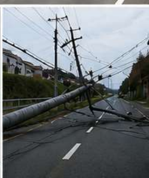
電柱倒壊による 道路閉塞
