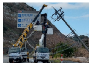
道路啓開作業
