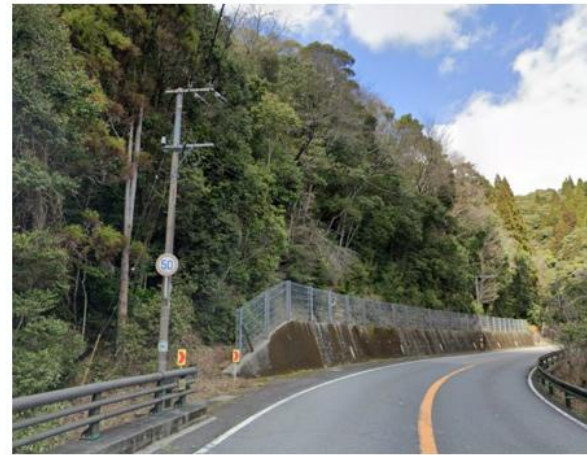
<大分県擁壁部>
